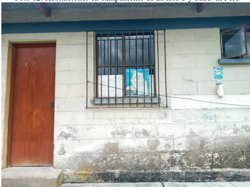
Foto 02. Habitaciones en campamento de EPIROC y Sandvik Perú
